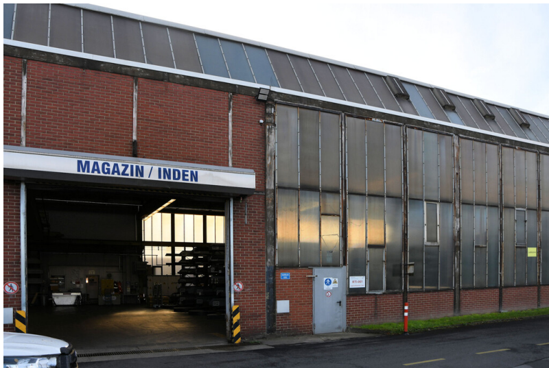
Tagebau Inden: Magazin / Lagerhalle, Eingang vom Lagerplatz aus, Ansicht von Norden; Foto: 09.11.2022 Fotograf/Urheber: Dr. Norbert Gilson
