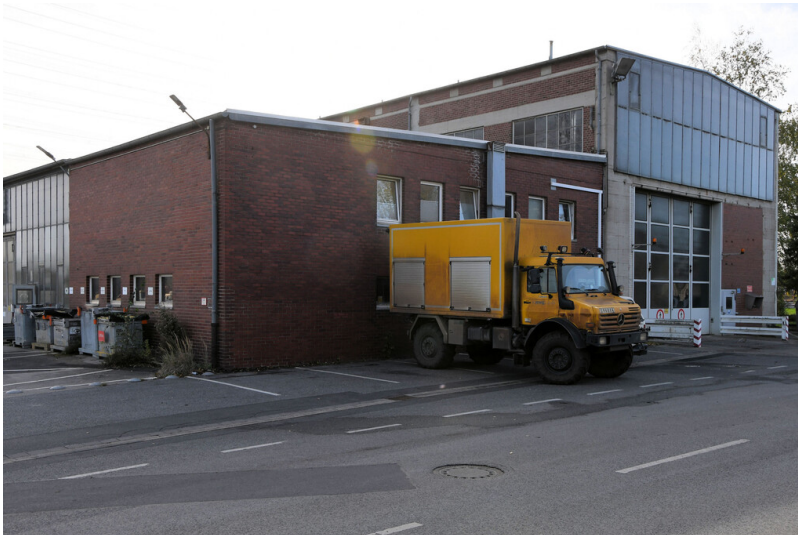
Tagebau Inden: Hilfsgeräte- und Kfz-Werkstatt, Ansicht von Nordosten; Foto: 09.11.2022 Fotograf/Urheber: Dr. Norbert Gilson
