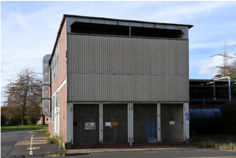
Tagebau Inden: Heizzentrale, Ansicht von Osten; Foto: 09.11.2022 Fotograf/Urheber: Dr. Norbert Gilson
