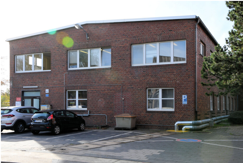
Tagebau Inden: Sozialgebäude Werkstattbereich (Haus K), Ansicht von Osten; Foto: 09.11.2022 Fotograf/Urheber: Dr. Norbert Gilson
