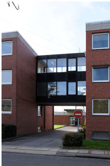
Tagebau Inden: Verbindungsbrücke zwischen Haus A und Haus B, Ansicht von Osten; Foto: 09.11.2022 Fotograf/Urheber: Dr. Norbert Gilson
