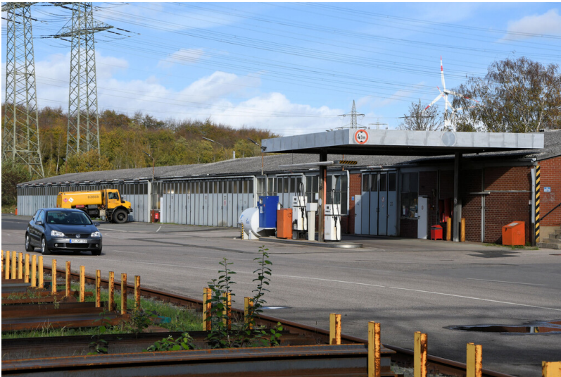
Tagebau Inden: Tankstelle, Pkw-Waschhalle, Garagen, Ansicht von Südwesten; Foto: 09.11.2022 Fotograf/Urheber: Dr. Norbert Gilson
