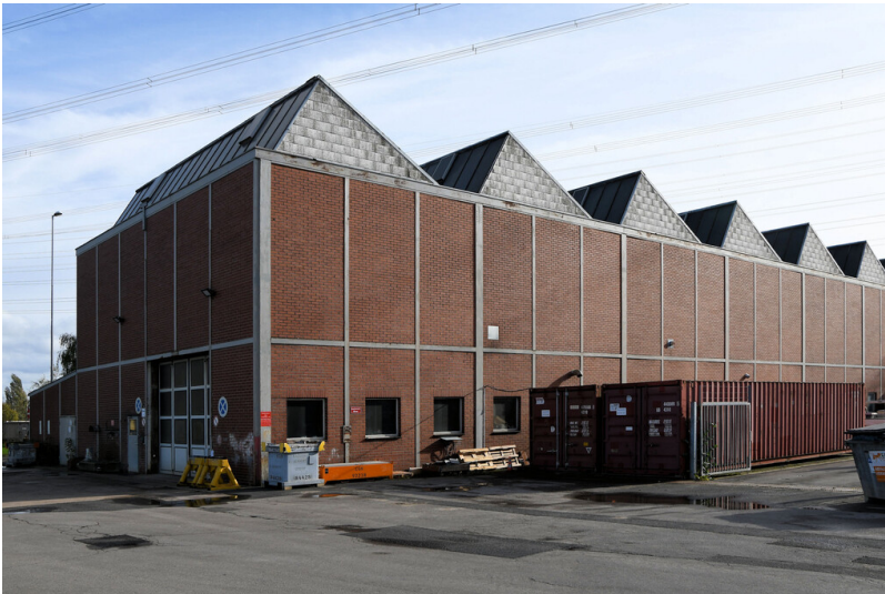
Tagebau Inden: Elektro-Werkstatt, Ansicht von Westen; Foto: 09.11.2022 Fotograf/Urheber: Dr. Norbert Gilson
