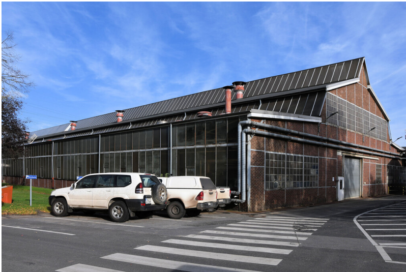
Tagebau Inden: Betriebswerkstatt (Haus W), Ansicht von Südwesten; Foto: 09.11.2022 Fotograf/Urheber: Dr. Norbert Gilson
