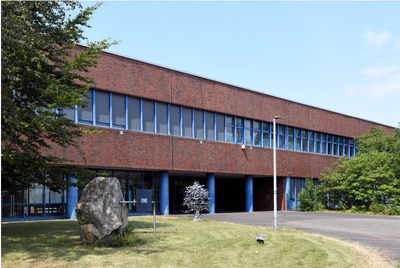
Tagebau Inden: Ausbildungszentrum, Ansicht von Südwesten; Foto: 26.06.2023 Fotograf/Urheber: Dr. Norbert Gilson
