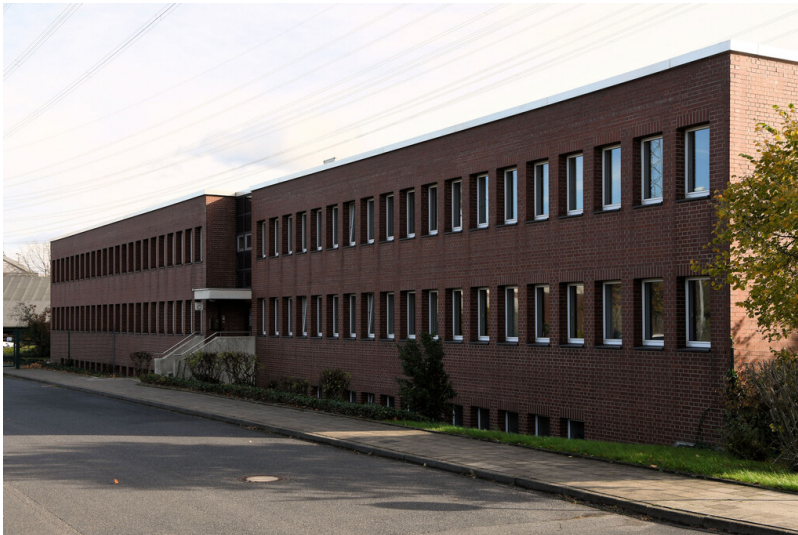
Tagebau Inden: Tagebauverwaltung, Ansicht von Westen; Foto: 09.11.2022 Fotograf/Urheber: Dr. Norbert Gilson
