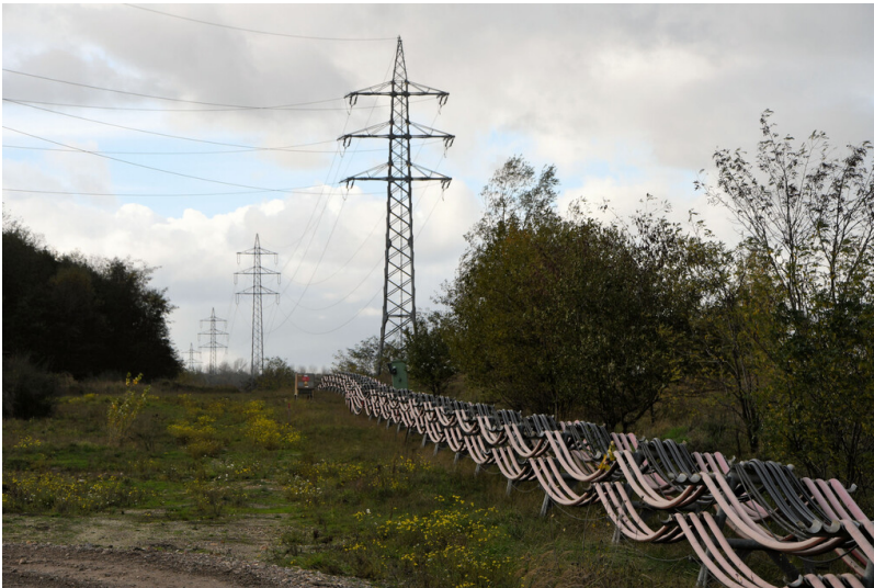
Tagebau Inden: zur Umspannanlage führende Leitungstrasse mit 110-kV-Freileitung und 25-kV-Kabelsträngen, Ansicht von Osten; Foto: 09.11.2022 Fotograf/Urheber: Dr. Norbert Gilson
