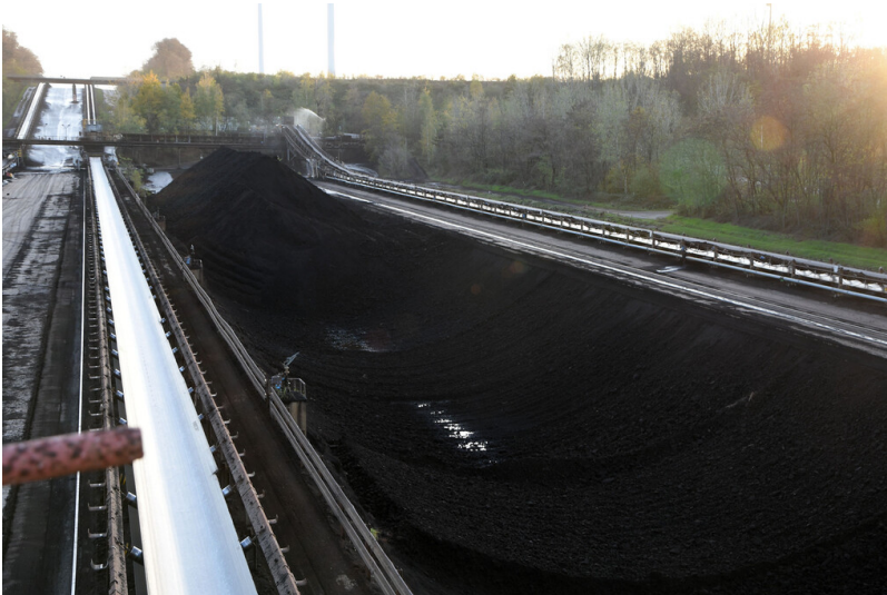
Tagebau Inden: Beginn der stationären Bandanlage zum Kraftwerk Weisweiler am Ausgang des Kohlebunkers Inden (hinten links), Ansicht von Nordosten; Foto: 09.11.2022 Fotograf/Urheber: Dr. Norbert Gilson
