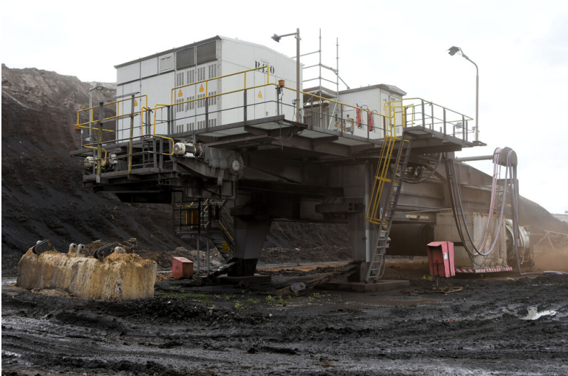
Tagebau Inden: Bandumkehre (Kopfstation) für 2.200-mm-Fördergurte mit Antrieb auf der 4. Sohle; Foto: 09.11.2022 Fotograf/Urheber: Dr. Norbert Gilson
