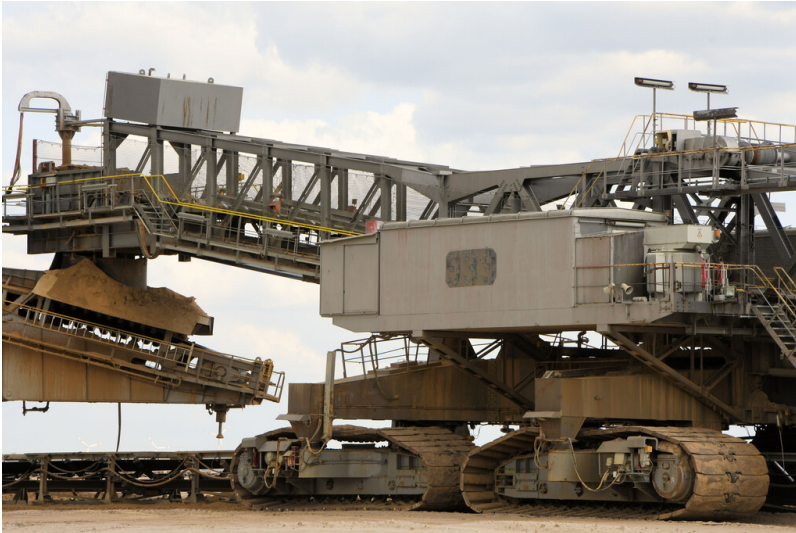
Tagebau Inden: Bandschleifenwagen 939, Übergabeausleger; Foto: 26.06.2023 Fotograf/Urheber: Dr. Norbert Gilson
