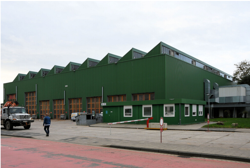
Tagebau Hambach: Werkstatt MA, Ansicht von Nordosten; Foto: 07.11.2022 Fotograf/Urheber: Dr. Norbert Gilson
