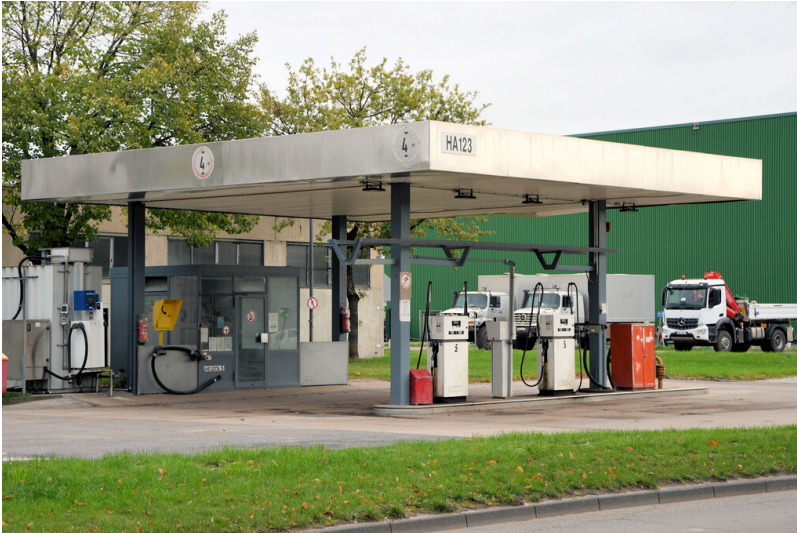
Tagebau Hambach: Betriebstankstelle in den Tagesanlagen, Ansicht von Nordwesten; Foto: 07.11.2022 Fotograf/Urheber: Dr. Norbert Gilson
