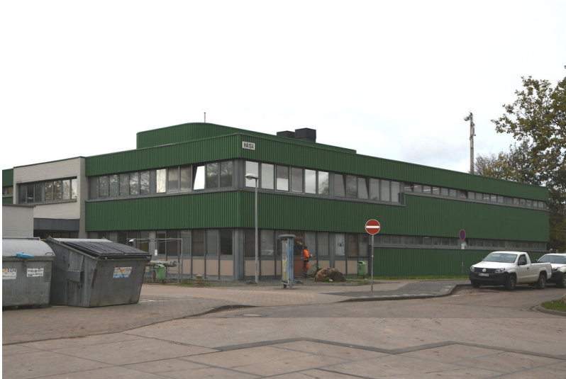
Tagebau Hambach: Sozialgebäude alt (Kaue 1, Bau HA 104), Ansicht von Südosten; Foto: 07.11.2022 Fotograf/Urheber: Dr. Norbert Gilson
