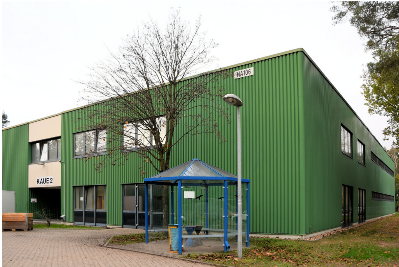
Tagebau Hambach: Neues Sozialgebäude (Kaue 2, Bau HA 106), Ansicht von Osten; Foto: 07.11.2022 Fotograf/Urheber: Dr. Norbert Gilson
