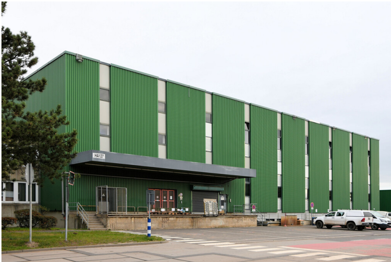
Tagebau Hambach: Magazinegebäude und Büro (Bau HA 127), Ansicht von Nordwesten; Foto: 07.11.2022 Fotograf/Urheber: Dr. Norbert Gilson
