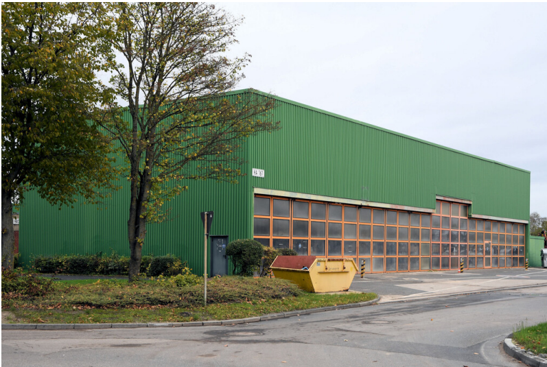
Tagebau Hambach: Kfz-Werkstatt, Ansicht von Südwesten; Foto: 07.11.2022 Fotograf/Urheber: Dr. Norbert Gilson
