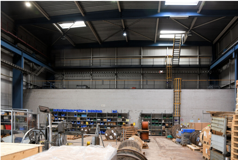
Tagebau Garzweiler: Kranhalle (Bau HA 126), Innenansicht; Foto: 26.06.2023 Fotograf/Urheber: Dr. Norbert Gilson
