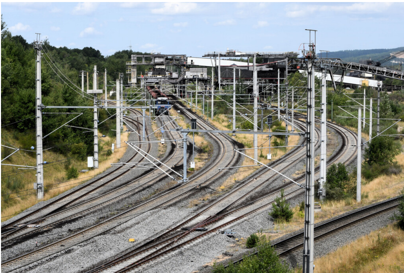
Tagebau Hambach: Anschlussgleise an die Hambachbahn, Ansicht von Südosten; Foto: 14.07.2023 Fotograf/Urheber: Dr. Norbert Gilson
