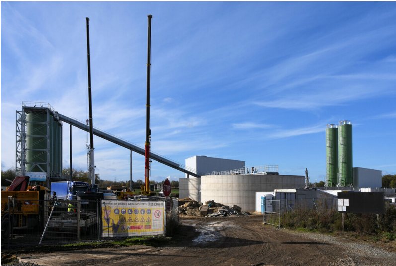
Tagebau Hambach: Baustelle der Grubenwasserreinigungsanlage Oberzier, Ansicht von Süden; Foto: 07.11.2022 Fotograf/Urheber: Dr. Norbert Gilson
