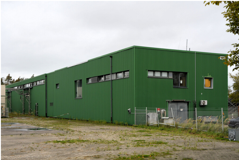
Station Hambach: 30-kV-Schaltheis mit Hauptschaltanlage Hambach, Ansicht von Süden; Foto: 07.11.2022 Fotograf/Urheber: Dr. Norbert Gilson
