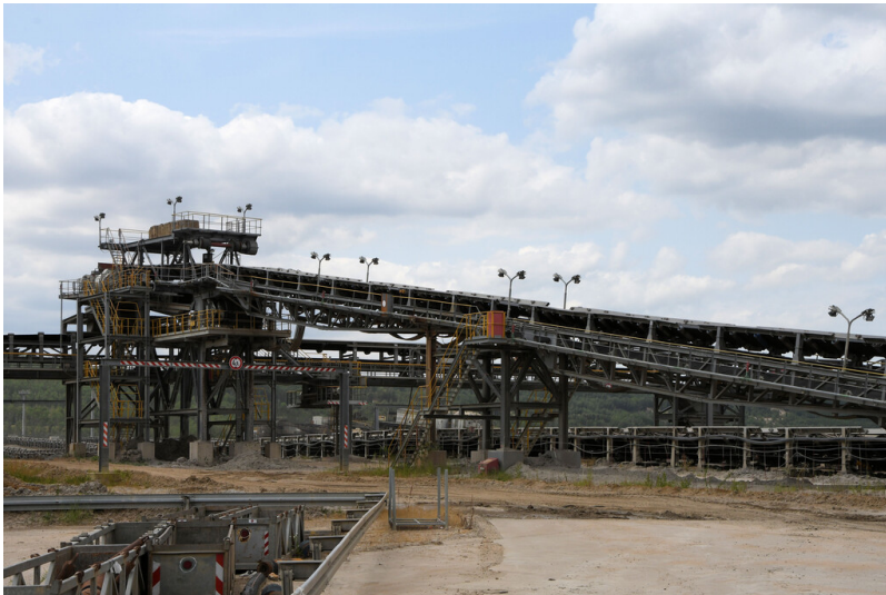
Tagebau Hambach: M2-Konverter, Aufgabe von Strossenband der 2. Sohle auf den M2-Konverter, Ansicht von Südosten; Foto: 26.06.2023 Fotograf/Urheber: Dr. Norbert Gilson
