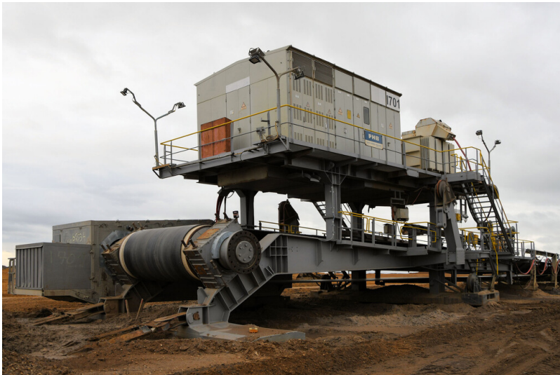
Tagebau Hambach: Bandumkehre B 2800 am Ende von Kippstrosse 7; Foto: 07.11.2022 Fotograf/Urheber: Dr. Norbert Gilson
