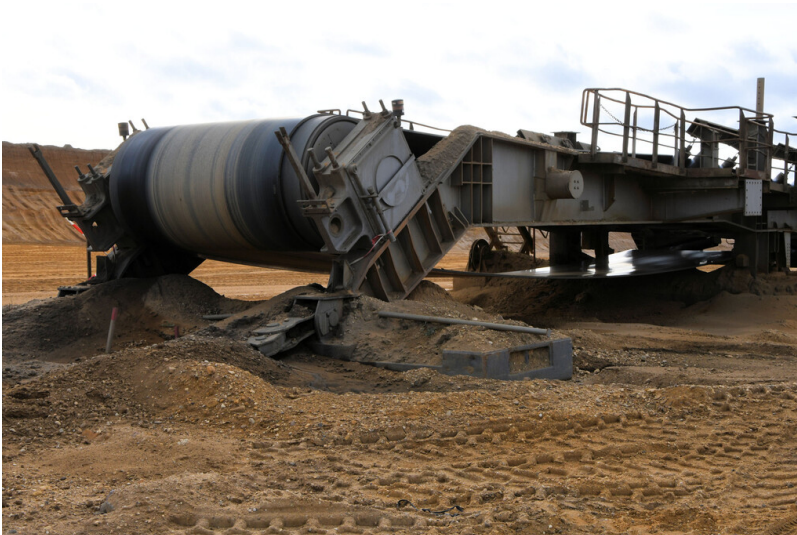
Tagebau Hambach: Umkehre der 2.200-mm-Bandanlage am Strossenende von Sohle 1; Foto: 07.11.2022 Fotograf/Urheber: Dr. Norbert Gilson
