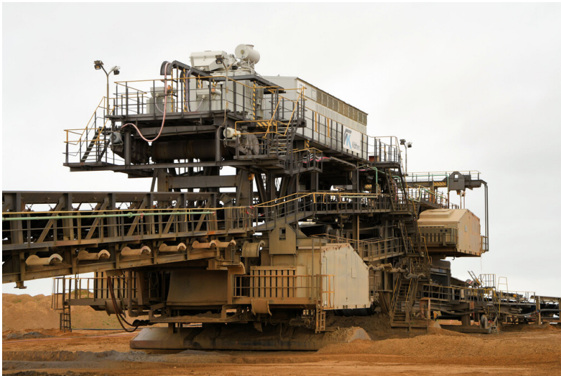
Tagebau Hambach: Bandantriebsstation 2.000 kW auf Kippstrosse 7, Bandauflaufseite; Foto: 07.11.2022 Fotograf/Urheber: Dr. Norbert Gilson
