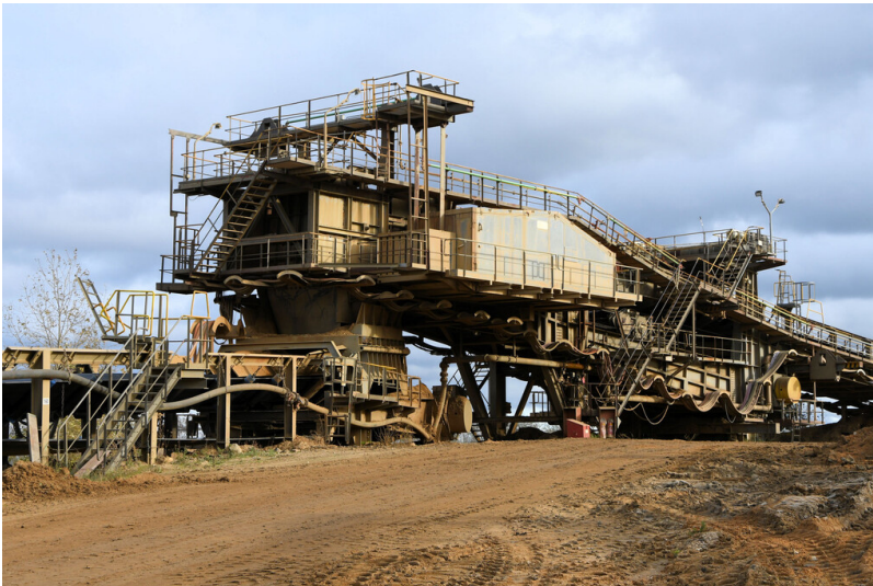
Tagebau Hambach: Bandantriebsstation 4 x 630 kW; Foto: 07.11.2022 Fotograf/Urheber: Dr. Norbert Gilson
