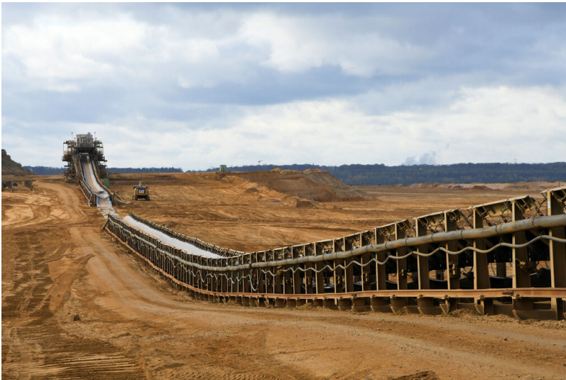
Tagebau Hambach: Bandanlage B 2200 auf der 1. Sohle; Foto: 07.11.2022 Fotograf/Urheber: Dr. Norbert Gilson
