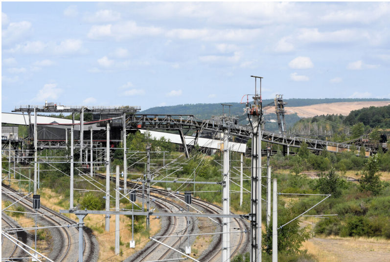
Tagebau Hambach: Zugbeladeanlage L70 mit offener Zuführungsbandbrücke, Ansicht von Südosten (Brücke über die Hambachbahn, Niederzier-Ellen); Foto: 14.07.2023 Fotograf/Urheber: Dr. Norbert Gilson
