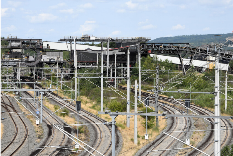
Tagebau Hambach: Zugbeladeanlage L60 mit eingehauster Zuführungsbandbrücke, Ansicht von Südosten (Brücke über die Hambachbahn, Niederzier-Ellen); Foto: 14.07.2023 Fotograf/Urheber: Dr. Norbert Gilson
