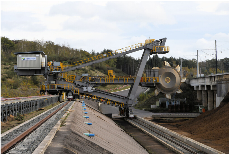
Tagebau Hambach: Aufnahmegerät 820 im Lösskippraben, Ansicht von Nordwesten; Foto: 07.11.2022 Fotograf/Urheber: Dr. Norbert Gilson
