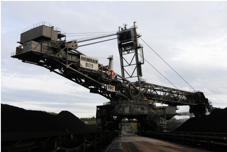
Tagebau Hambach: Schaufelrad-Aufnahmegerät 809 in Bunker 1; Foto: 07.11.2022 Fotograf/Urheber: Dr. Norbert Gilson
