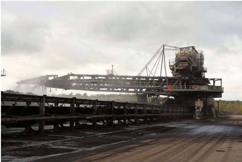
Tagebau Hambach: Bandschleifenwagen 989 im Bunkerschiff 1; Foto: 07.11.2022 Fotograf/Urheber: Dr. Norbert Gilson
