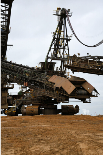
Tagebau Hambach: Absetzer 761, Aufgabevorrichtung von Bandschleifenwagen 952 auf das Zubringerband; Foto: 07.11.2022 Fotograf/Urheber: Dr. Norbert Gilson
