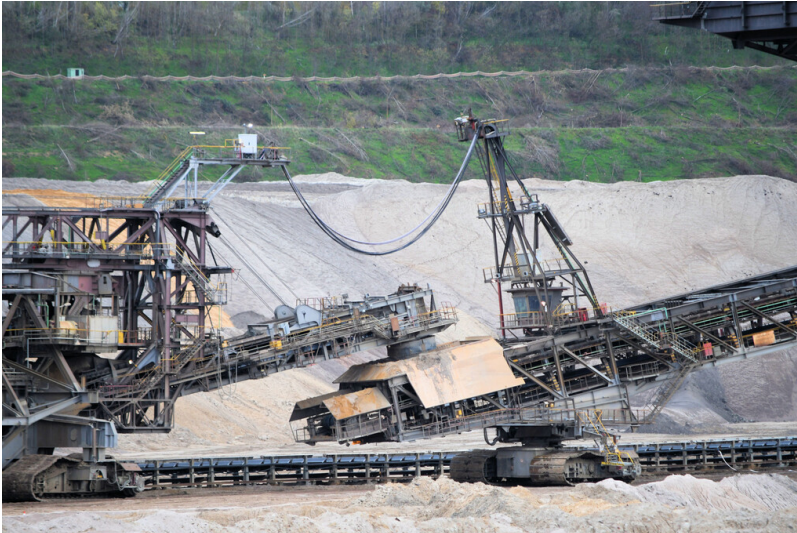
Tagebau Hambach: Absetzer 759, Übergabevorrichtung vom Bandschleifenwagen 950 auf den Zubringerausleger; Foto: 07.11.2022 Fotograf/Urheber: Dr. Norbert Gilson
