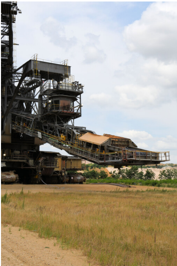
Tagebau Hambach: Absetzer 744, Zubringerbandbrücke; Foto: 26.06.2023 Fotograf/Urheber: Dr. Norbert Gilson
