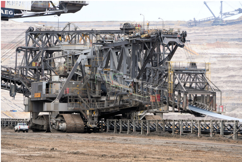
Tagebau Hambach: Bandschleifenwagen 944, Auflaufteil; Foto: 07.11.2022 Fotograf/Urheber: Dr. Norbert Gilson
