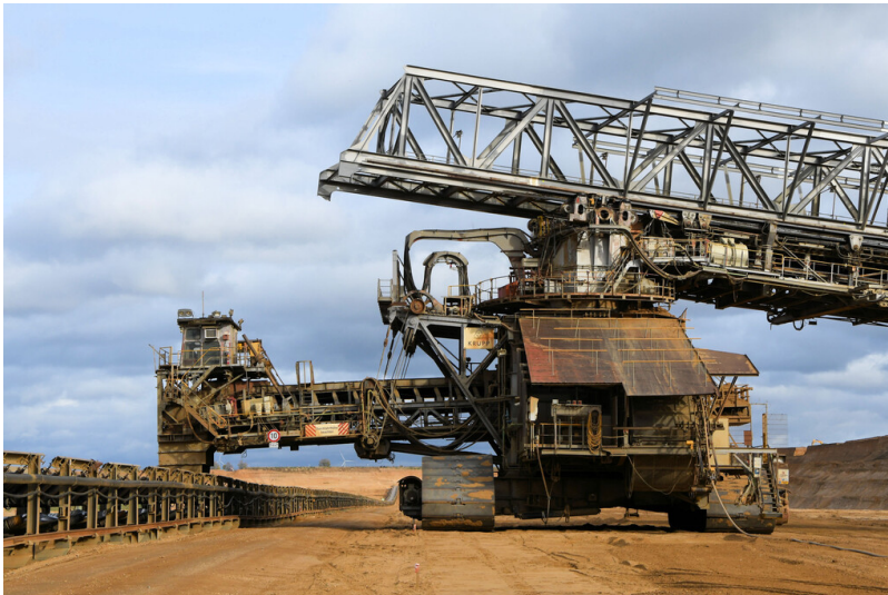
Tagebau Hambach: Schaufelradbagger 291, Bandbeladewagen mit Übergabeausleger und Bandbeladekopf; Foto: 07.11.2022 Fotograf/Urheber: Dr. Norbert Gilson
