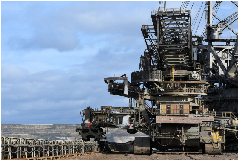
Schaufelradbagger 290: Bandbeladewagen mit Übergabeausleger und Beladepopf; Foto: 07.11.2022 Fotograf/Urheber: Dr. Norbert Gilson
