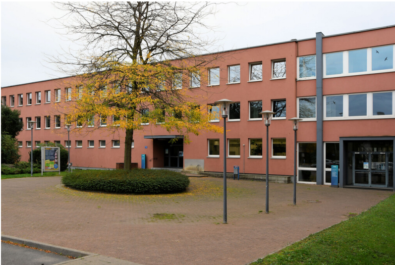
Tagebau Garzweiler: Tagebauverwaltung, ehemaliges EA-Gebäude, Ansicht von Norden; Foto: 03.11.2022 Fotograf/Urheber: Dr. Norbert Gilson
