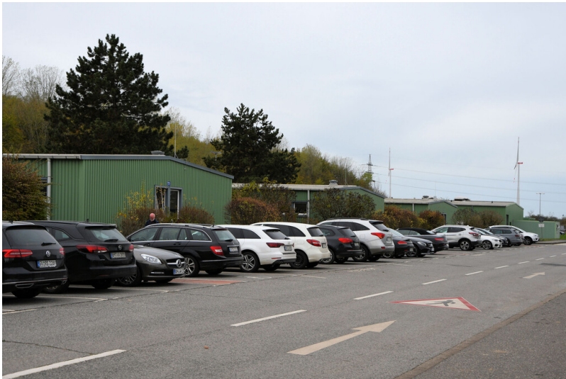
Tagebau Garzweiler: Stützpunktgebäude für die Bergbauabteilung, Ansicht von Nordosten; Foto: 03.11.2022 Fotograf/Urheber: Dr. Norbert Gilson
