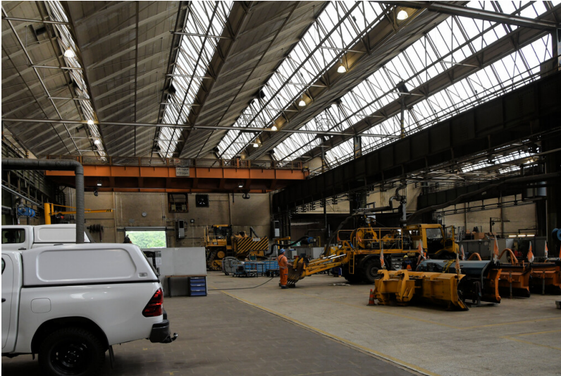
Tagebau Garzweiler: Maschinentechnische Betriebswerkstatt, südlicher Hallenbereich, Ansicht von Osten; Foto: 26.06.2023 Fotograf/Urheber: Dr. Norbert Gilson
