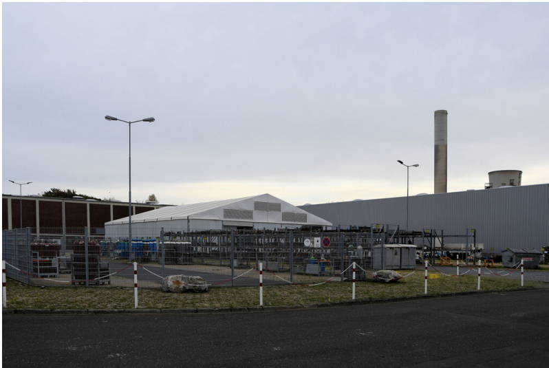
Tagebau Garzweiler: Materiallagerplatz, Ansicht von Südwesten; Foto: 03.11.2022 Fotograf/Urheber: Dr. Norbert Gilson
