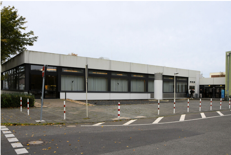
Tagebau Garzweiler: Kantinegebäude, Ansicht von Nordosten; Foto: 03.11.2022 Fotograf/Urheber: Dr. Norbert Gilson
