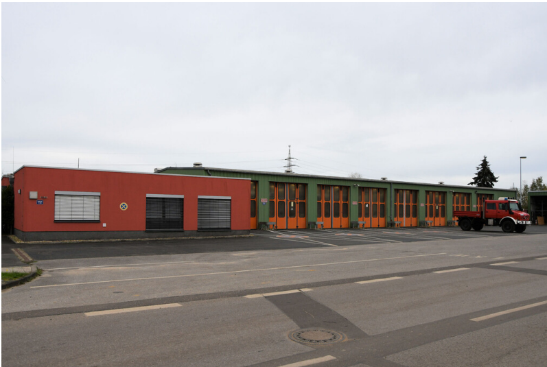
Tagebau Garzweiler: Feuerwehr- und Sanitätsstützpunkt, Ansicht von Osten; Foto: 03.11.2022 Fotograf/Urheber: Dr. Norbert Gilson
