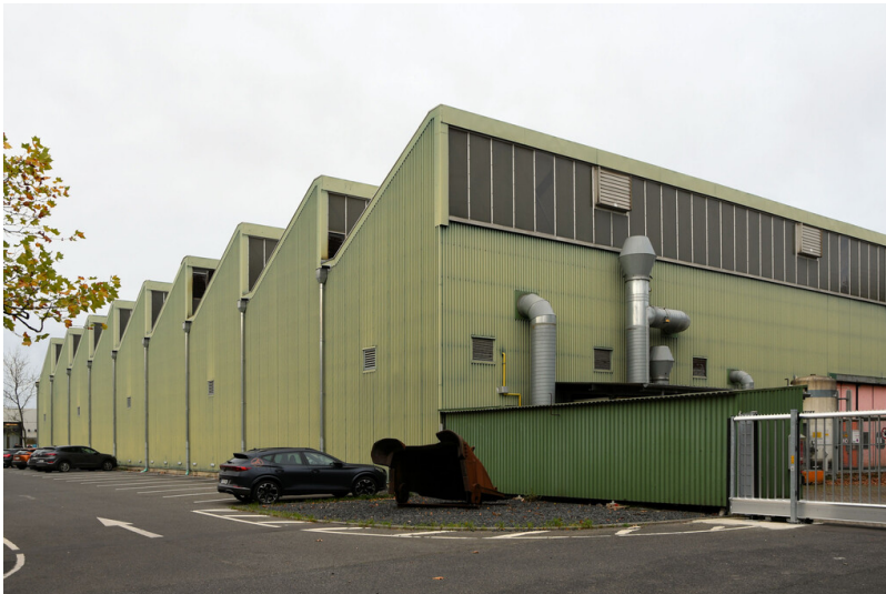
Tagebau Garzweiler: Ausbildungsstätte Gustorf, Ansicht von Nordosten; Foto: 03.11.2022 Fotograf/Urheber: Dr. Norbert Gilson
