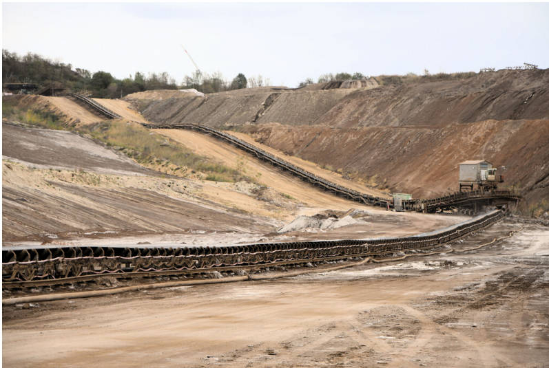
Tagebau Garzweiler: Aschebandanlage in der Kraftwerksrückstandsdeponie, Ansicht von Osten; Foto: 03.11.2022 Fotograf/Urheber: Dr. Norbert Gilson
