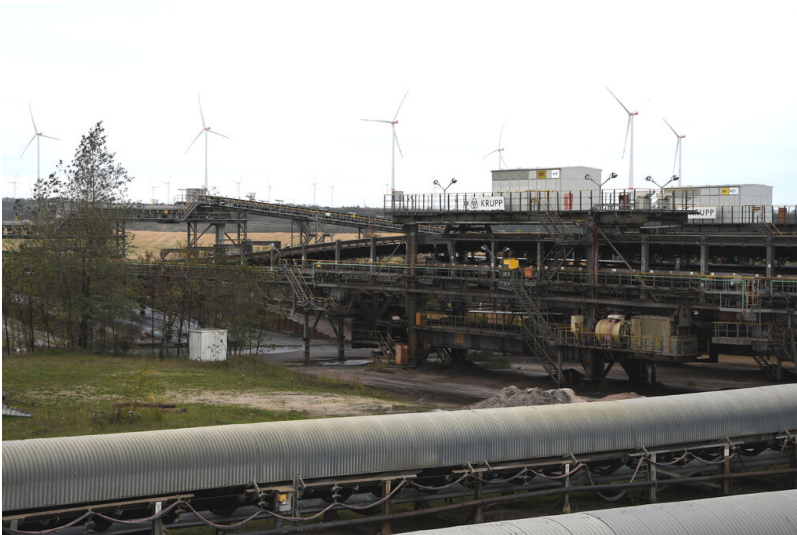
Tagebau Garzweiler: Verschiebeköpfe am Bandsammelpunkt Kohlebunker West, Ansicht von Nordosten; Foto: 03.11.2022 Fotograf/Urheber: Dr. Norbert Gilson
